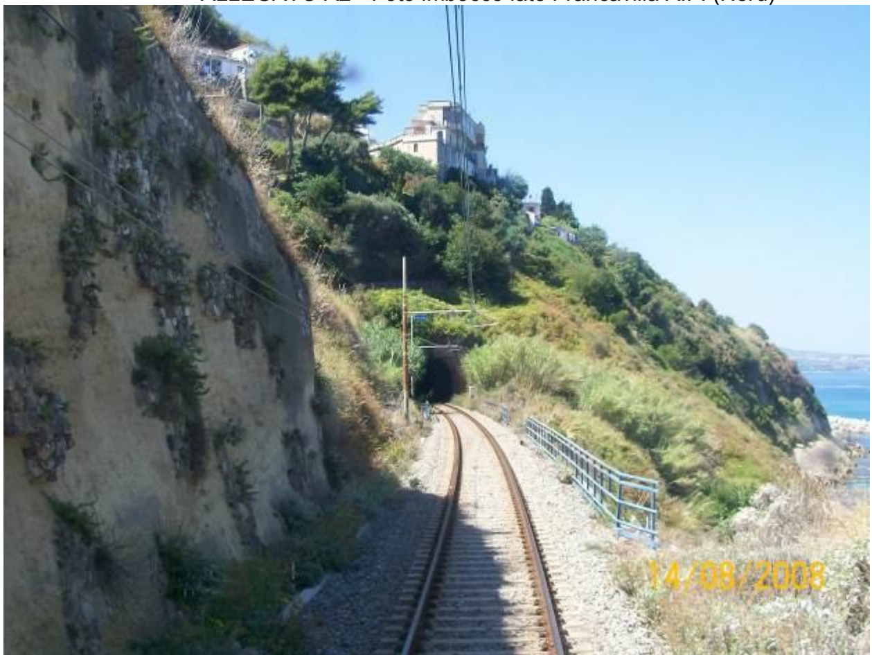
ALLEGATO A2 - Foto imbocco lato Francavilla A.F. (Nord)
