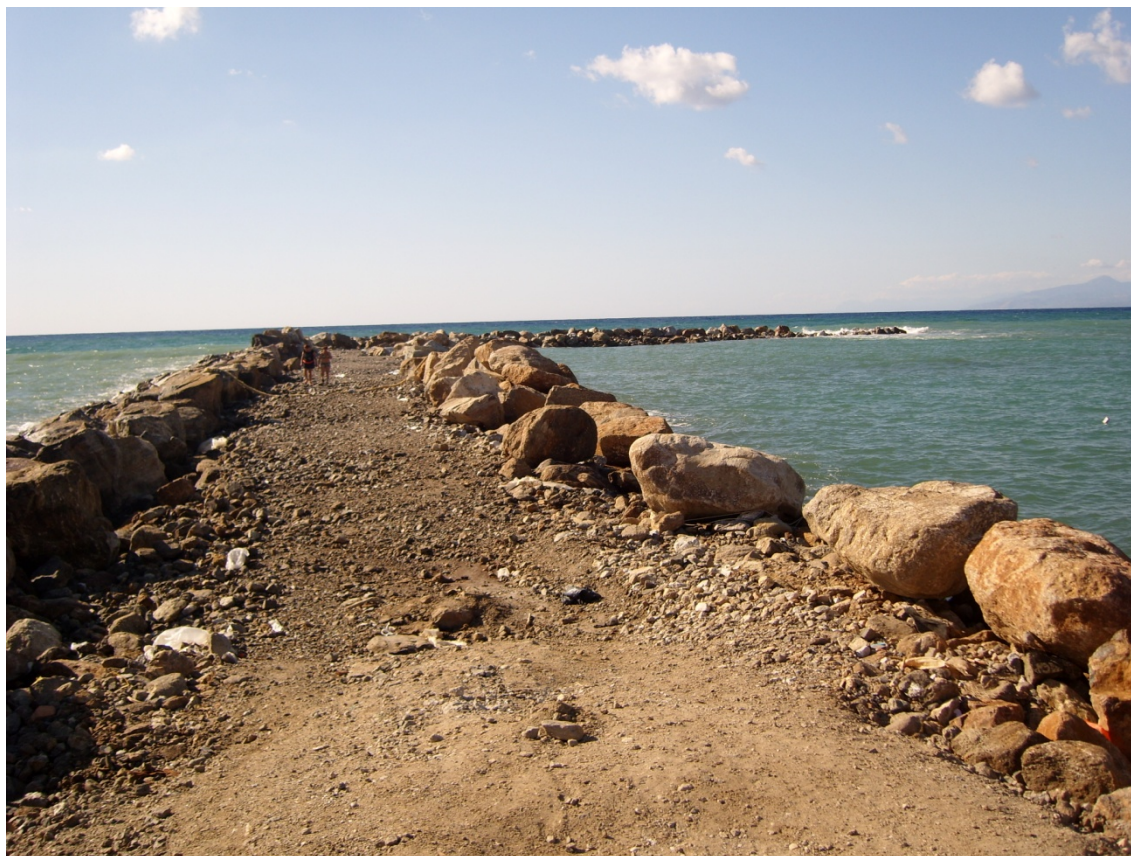
Figura 13 – Pennello di progetto in durante le fasi di realizzazione
