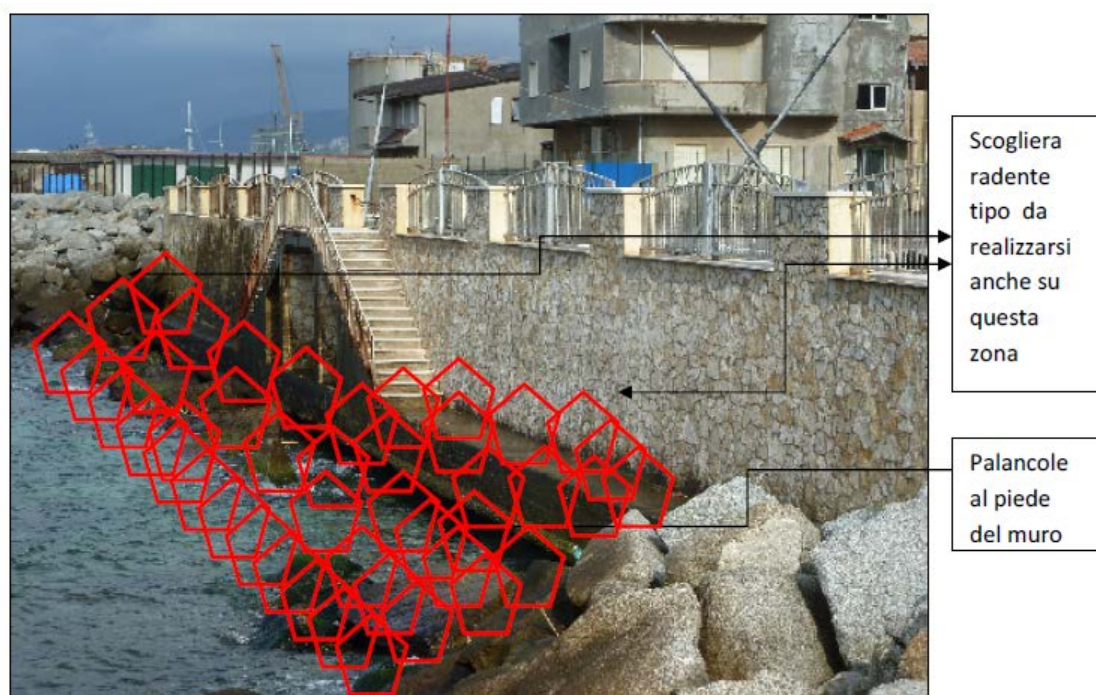
Figura 1 – Progetto originario - Sezione schematica realizzazione palancolata
