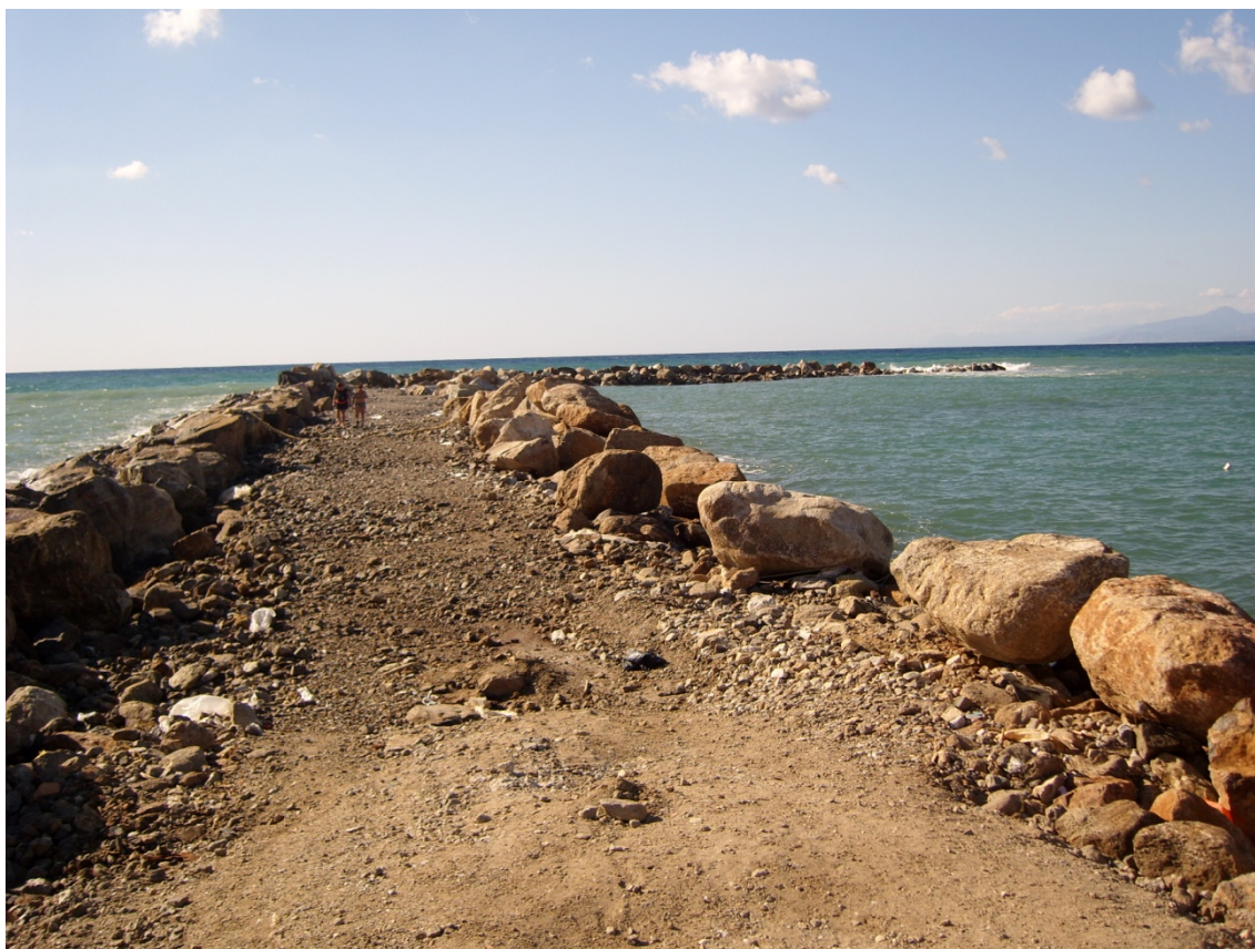
Figura 15 – Pennello di progetto in durante le fasi di realizzazione
