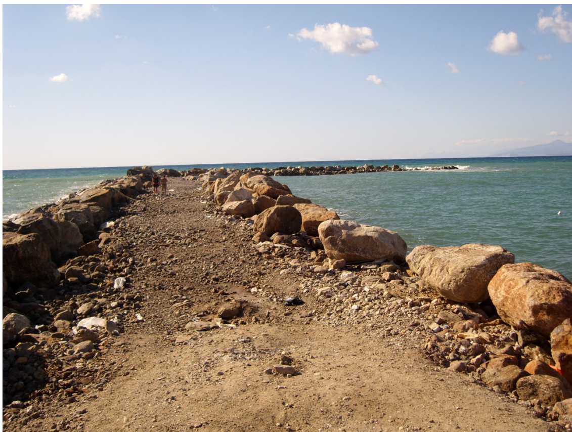
Figura 21 – Pennello di progetto in durante le fasi di realizzazione
