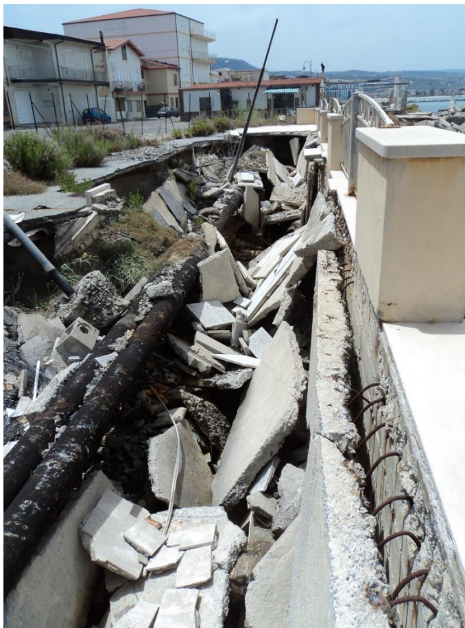
Figura 3 – Litorale di Vibo Valentia – Pavimentazione sifonata Località Capannina
