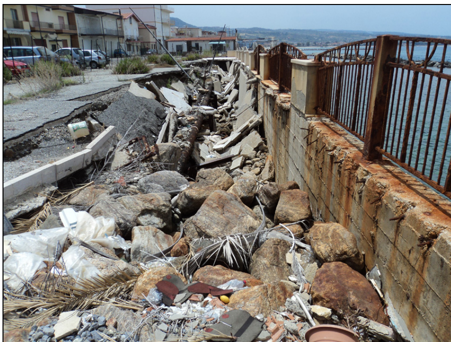
Figura 3 – Foto del dissesto a monte del muro per effetto del sifonamento
