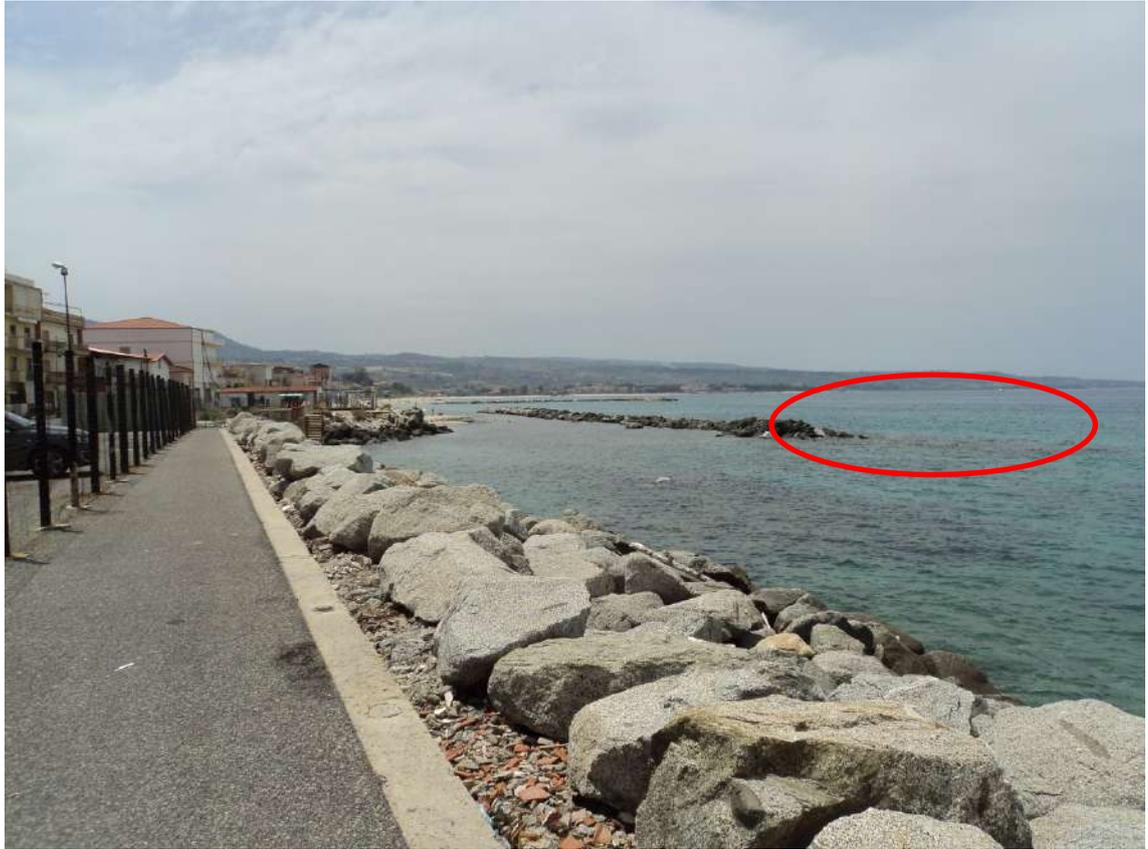
**Figura 1 – Barriera esistente – Rifiorimento della testata per circa 45 m**
